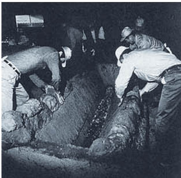
Рабочие отстраивают тата́ра заново перед каждой плавкой
